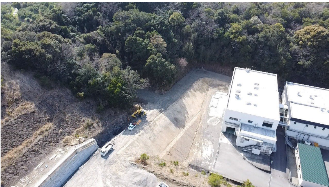
搬入道路（令和6年3月撮影）
