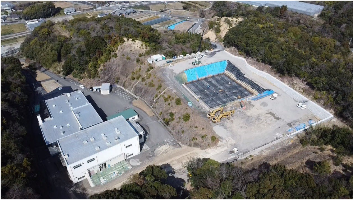
工事現場（令和6年3月撮影）
