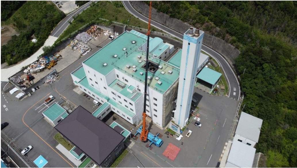
1系ガス冷却室搬入（令和4年6月撮影）
