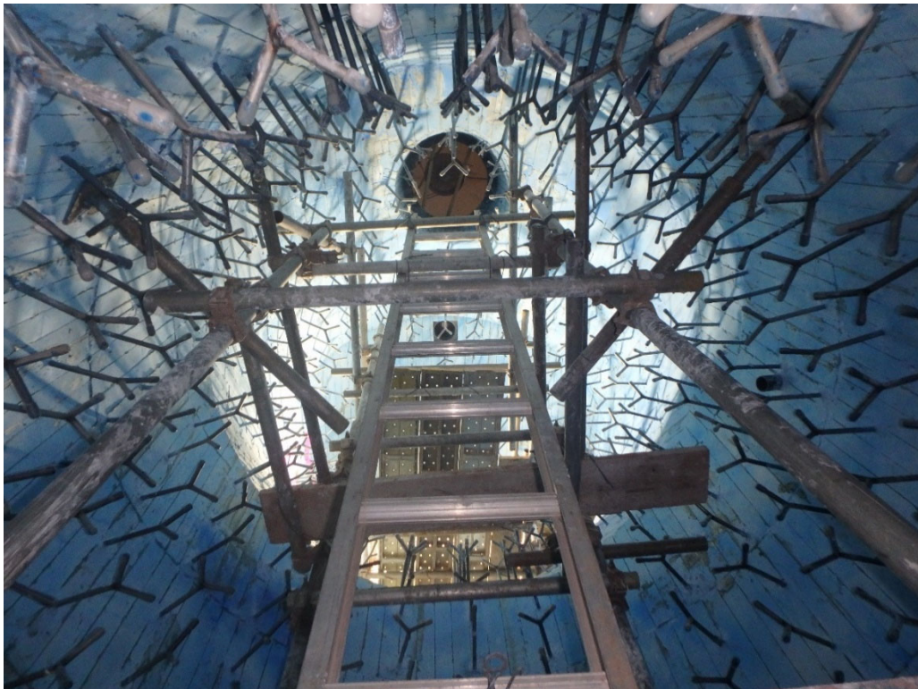
1系焼却炉 断熱ボード取付状況（令和4年9月撮影）
