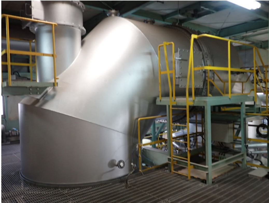
1系連絡ダクト（令和5年3月撮影）
