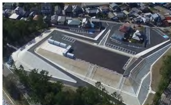
(松原地区高台津波避難場所)
