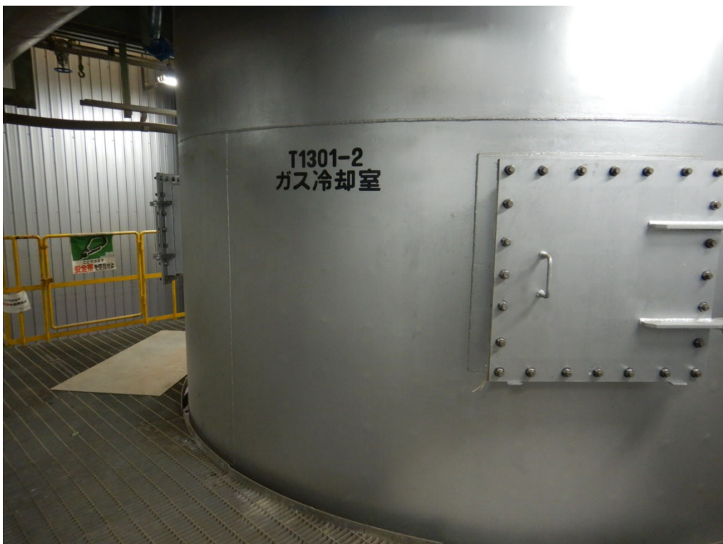
ガス冷却室（令和4年3月撮影）
