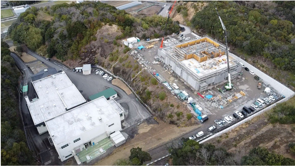
工事現場（令和7年3月撮影）
