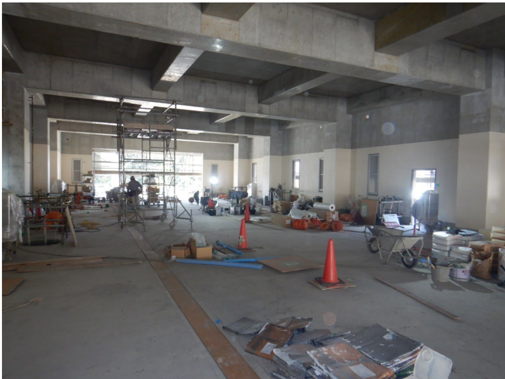
1階受入室（令和7年3月撮影）
