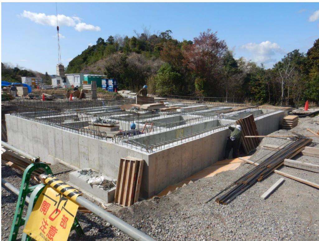
洗車場（令和 7 年 3 月撮影）
