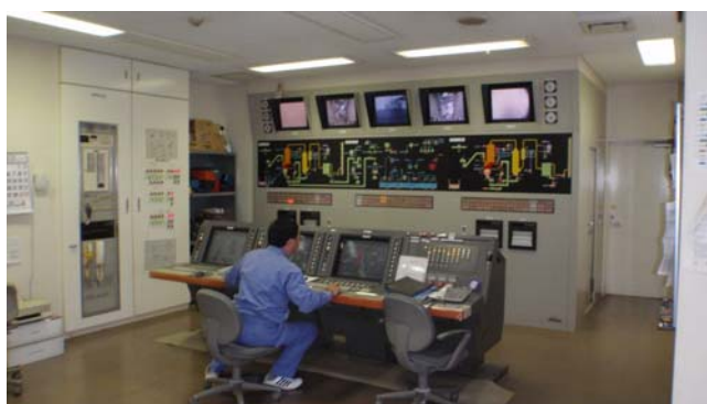
(ごみ焼却運転管理業務の一部民間委託：中央制御室)
