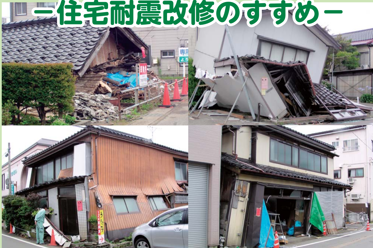
新潟県中越沖地震（平成19年7月16日）
