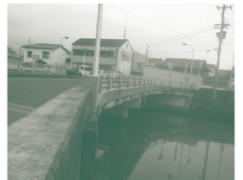
▲耐震補強が予算化された湯浅町の北橋
