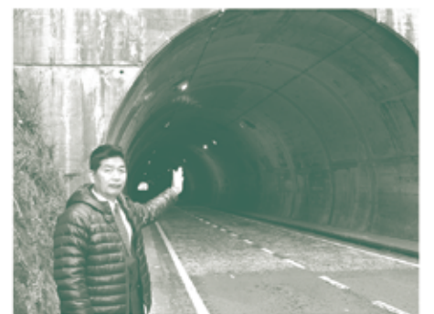
▲照明施設が改修され、LEDライトがつけられた国道480号の尾岩坂トンネル
