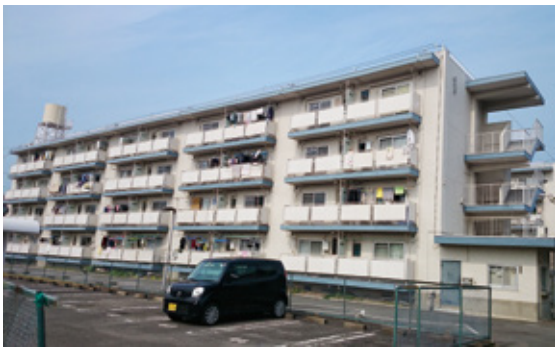
▲湯浅町港の雇用促進住宅
