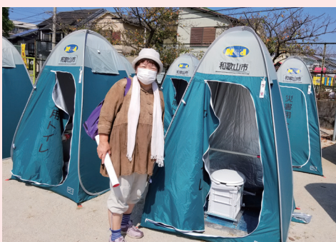
奥村規子県議 断水中の和歌山市内に設置されたマンホールトイレを調査
