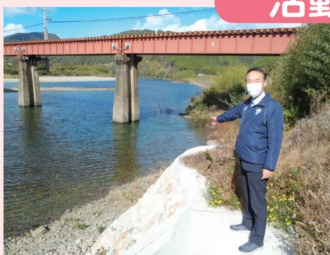
高田由一県議 護岸の傷みを調査（日置川）
