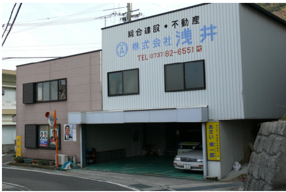
賃借料の支払いが議員の利益になっているとされた(株)浅井の建物。
