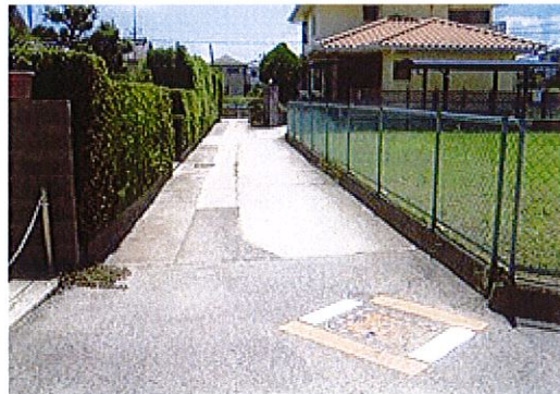
降雨のたびに冠水していた住宅地内の道路と家屋
