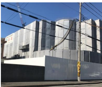
建設中の伏虎義務教育学校
